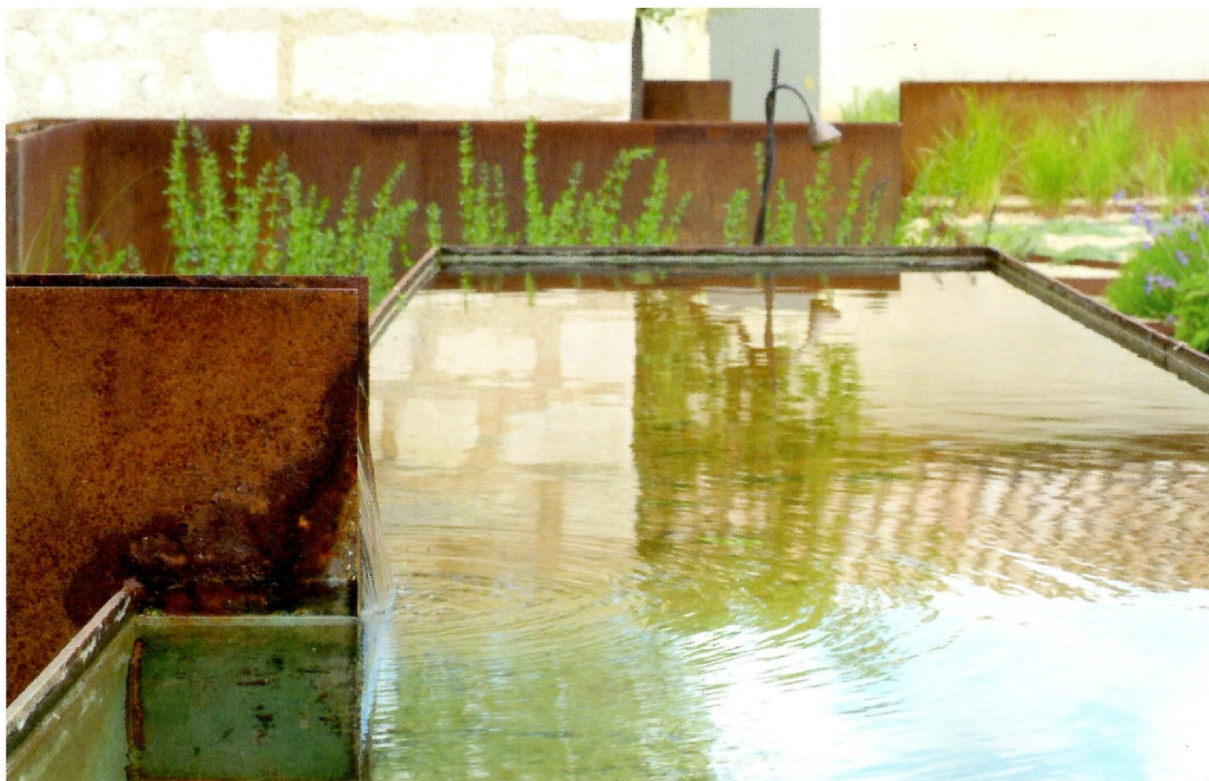
Esthétique, le circuit de bassin est à l'image des cours d'eau dans le paysage alentour, et apporte une touche vivante dans ce tableau très graphique. Écologique, il fonctionne en circuit fermé.
